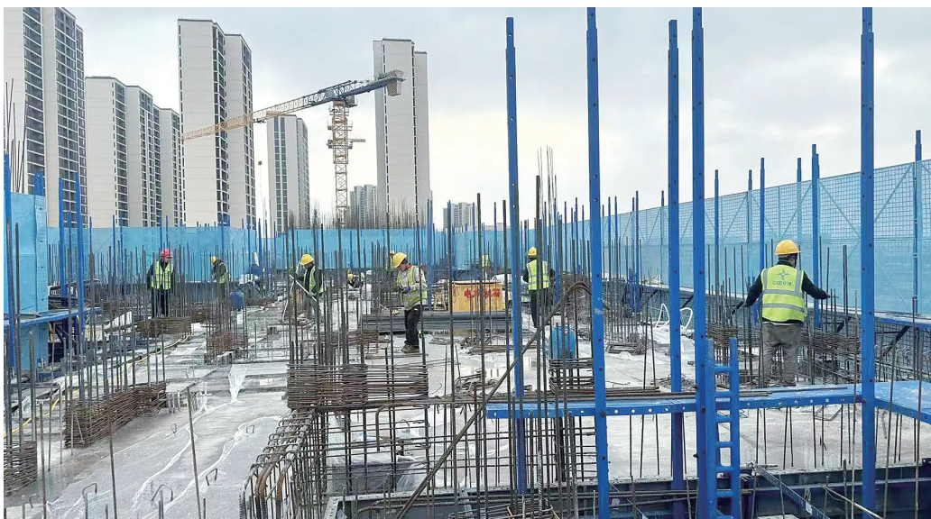
新厝安置房项目建设顺利推进。
